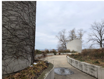
Figure 14. Shelter Rooftop (Bernhardt, 2018)
