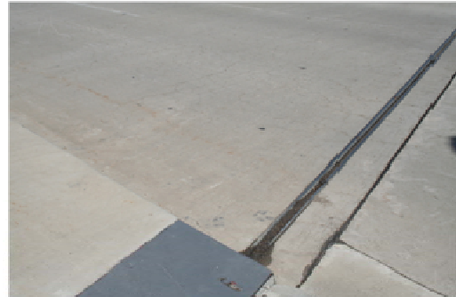
(d) B-40-686 East Support (No Cracks)
