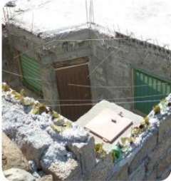
Water Tank - Reservatório de água
